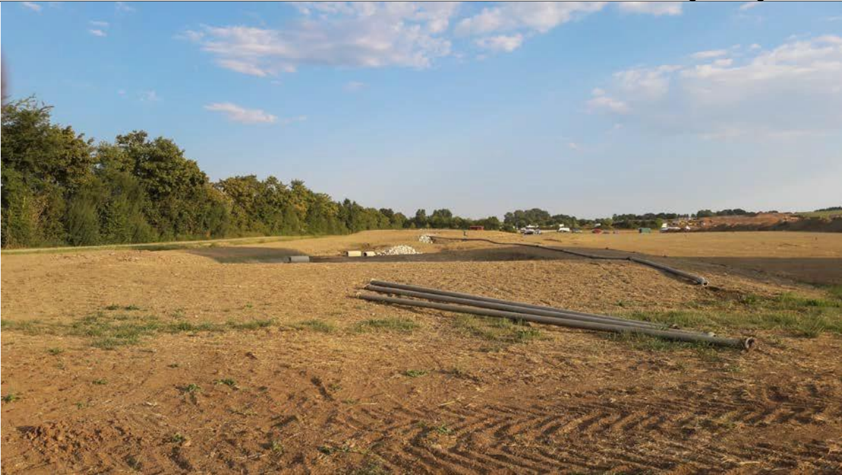
Ersatzmaßnahme 1 Bauzustand Juli 2018
